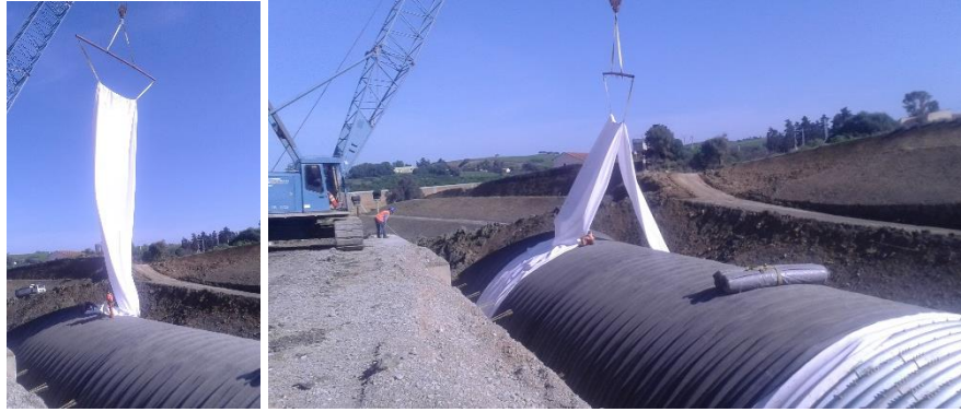
Figure 16. Mise en place du géotextile de protection sur la géomembrane EPDM (partie sup.)
