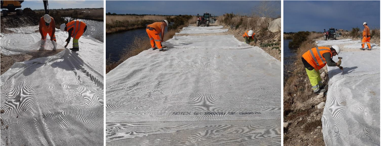
Figure 9. Découpe, pose des lès, recouvrements et agrafage
