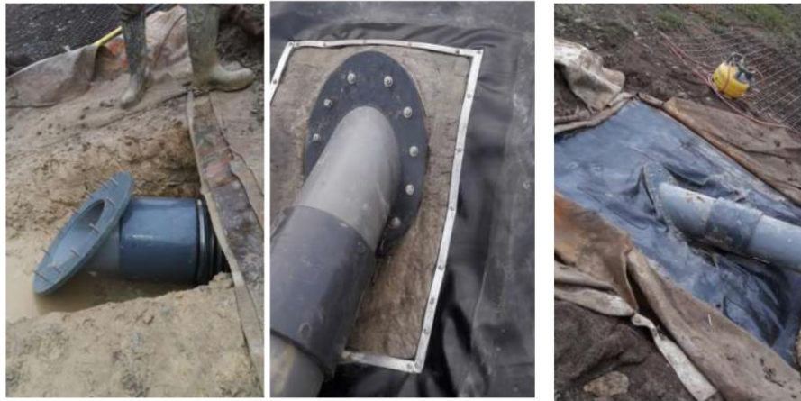
Figure 9. Nouveau dispositif d'étanchéité autour de la canalisation PVC
