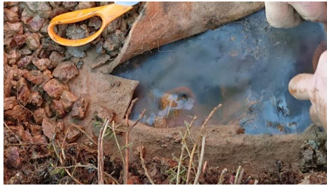
Figure 10. Perforation de la géomembrane par les agrafes
