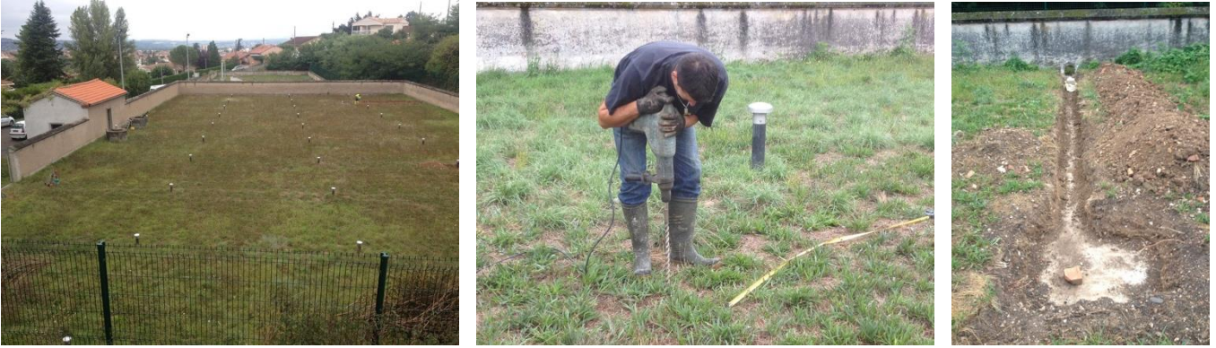
Figure 26 . Emprises couvertures – Sondages dans les remblais des cuves 1886 et 1947
