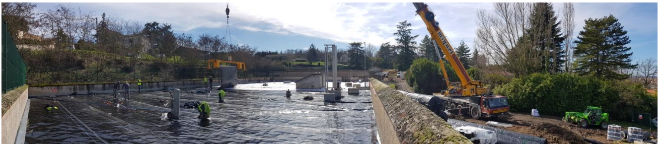
Figure 30. Vue d'ensemble mise en œuvre étanchéité sur cuves R1 et R2
