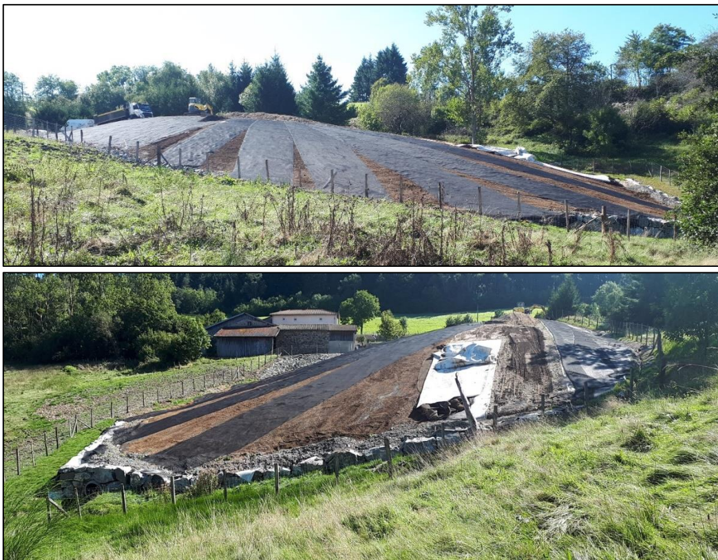
Figure 7. Vue de la pose de la barrière physique permettant la mise en place des matériaux sains (source BRGM)
