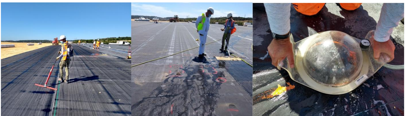
Figure 11. Méthodes de l'arc électrique, de la flaque d'eau et de la cloche à vide, de gauche à droite
