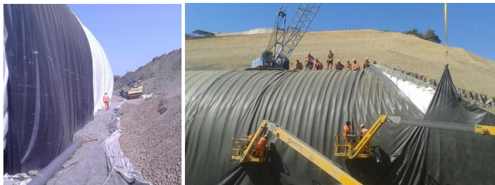
Figure 15. Mise en place de la géomembrane EPDM sur le géotextile de protection (partie sup.)
