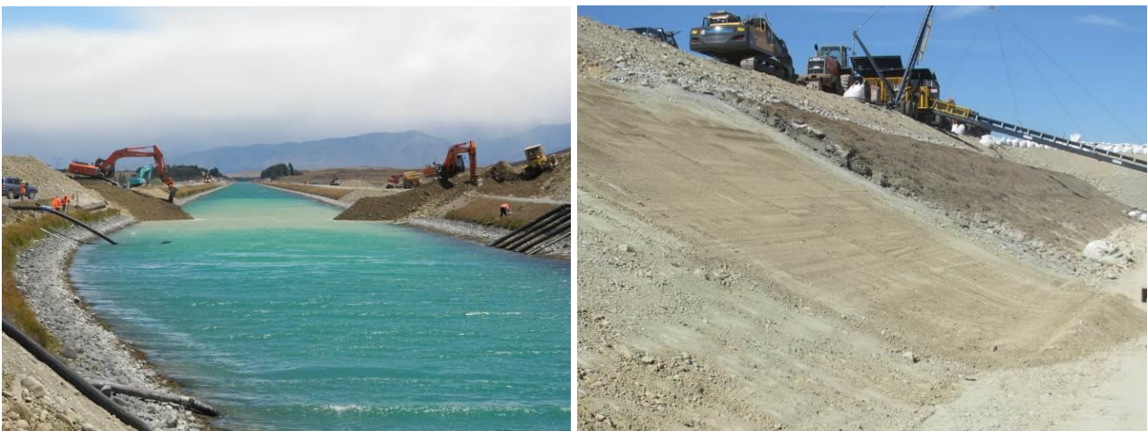
Figure 2. Construction du batardeau (Phase 1), et préparation de surface : procédant du premier plan à l'arrière-plan, la surface profilée, le traitement de surface, et la surface du canal après assèchement.
