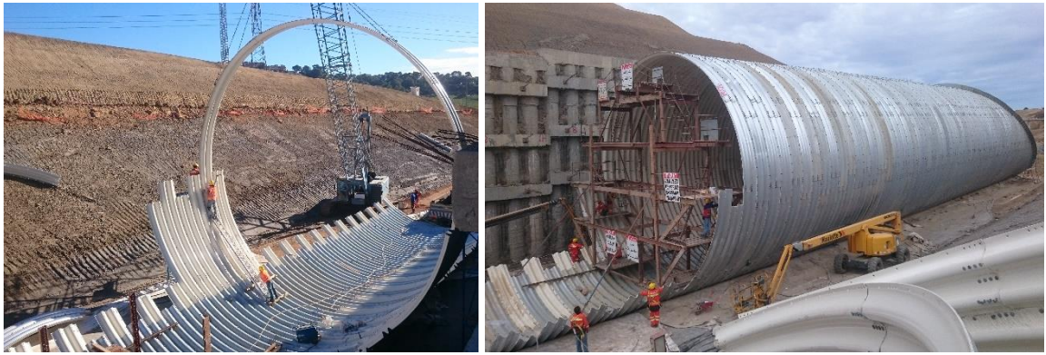
Figure 12. Assemblage de la structure en acier ondulé par la méthode anneau par anneau
