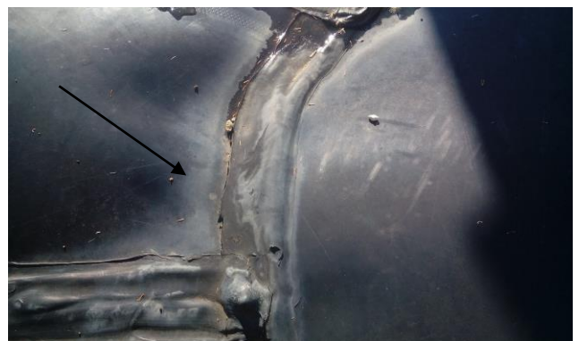
Figure 9b. Décollement d'extrusion
