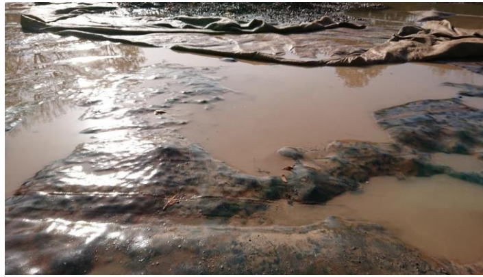
Figure 7. Vue du support très irrégulier
