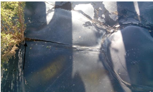
Figure 9a. Fissuration de bordure d'extrusion
