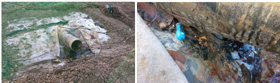
Figure 8. Canalisation d'entrée avec déchirure de la géomembrane en partie inférieure
