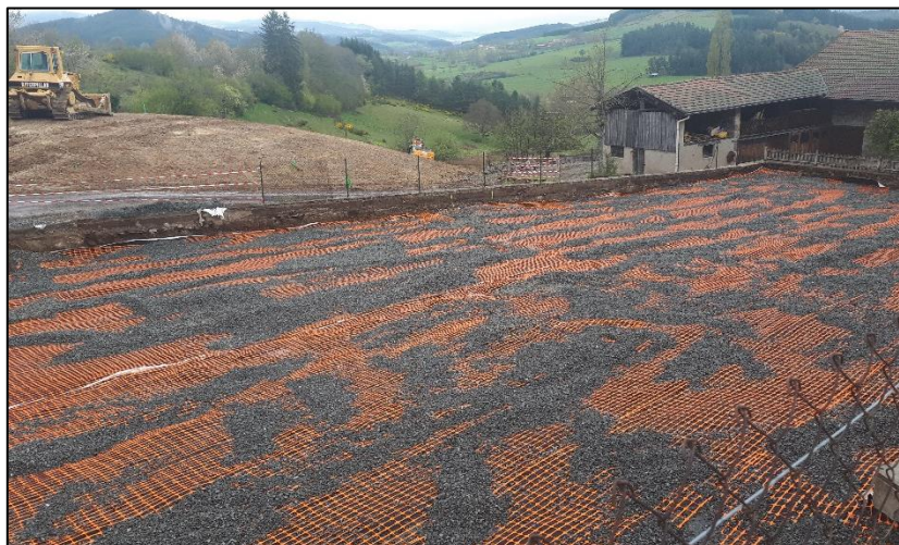
Figure 9. Vue de la barrière mise en place au niveau d'un des jardins potagers avant mise en place de la terre végétale (source BRGM)
