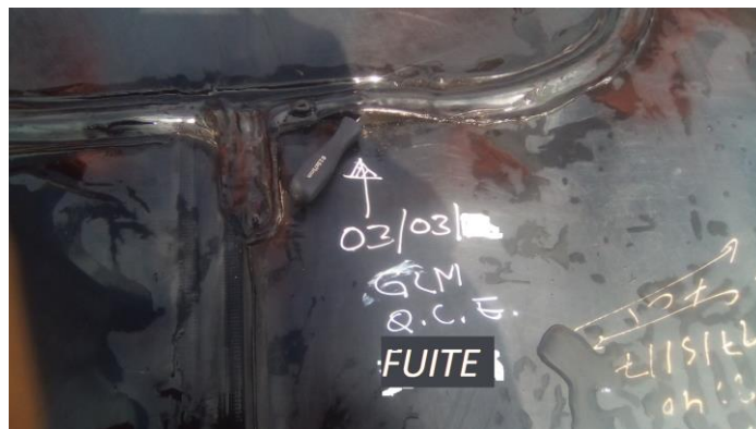
Figure 6. Contrôle au balai/feuille, fuite franche de 5 cm sur pièce extrudée, non détectée lors des contrôles visuels et à la cloche à vide
