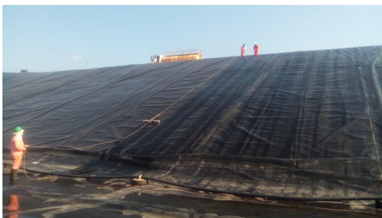
Figure 4. Contrôle au balai électrique - flaque sur les talus
