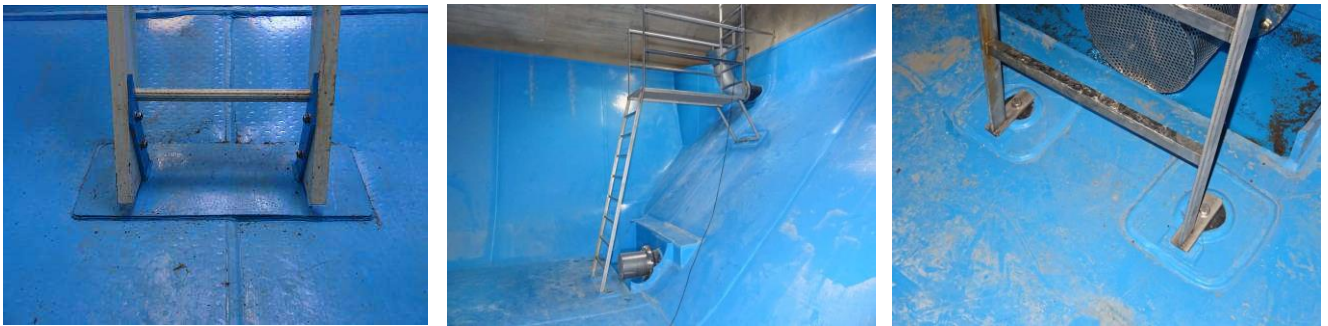
Figures 23, 24 et 25. Exemples de traitement de points singuliers (moyens d'accès)
