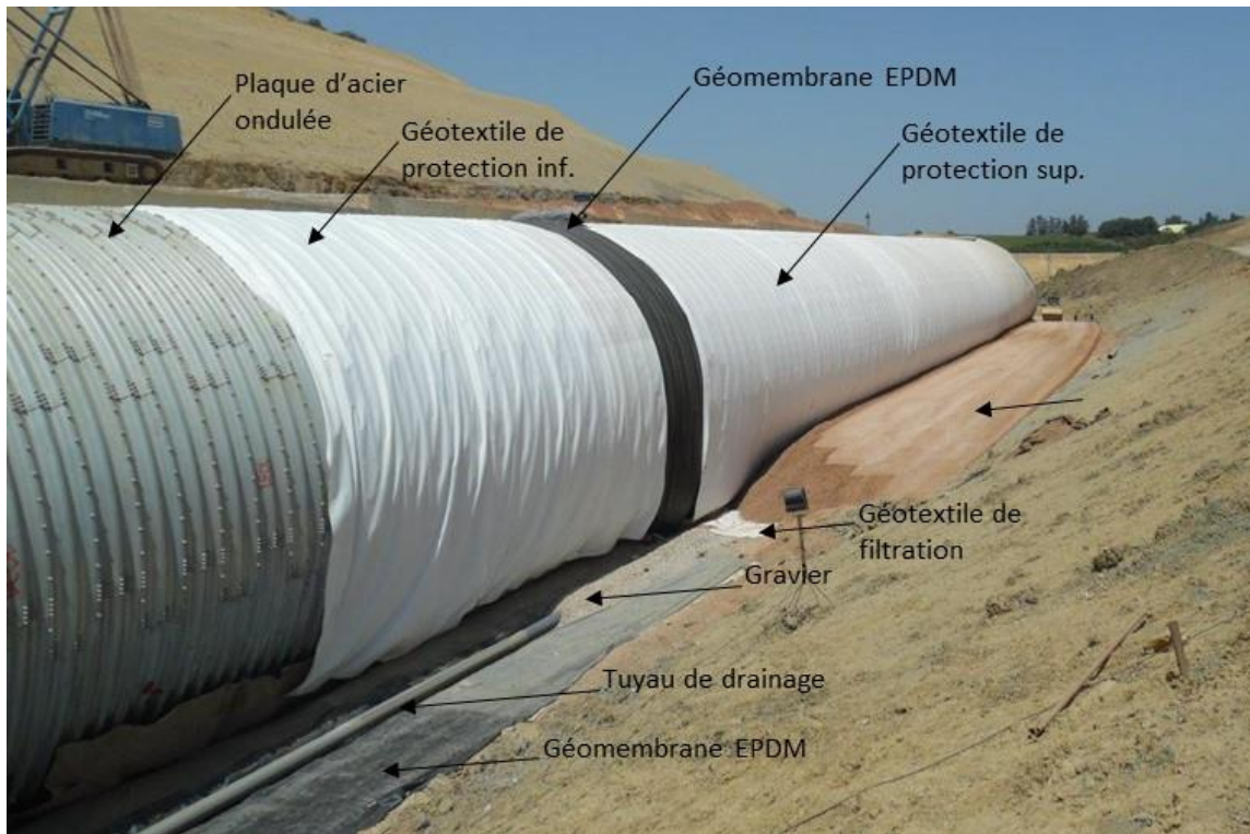
Figure 17. Différents éléments du chantier
