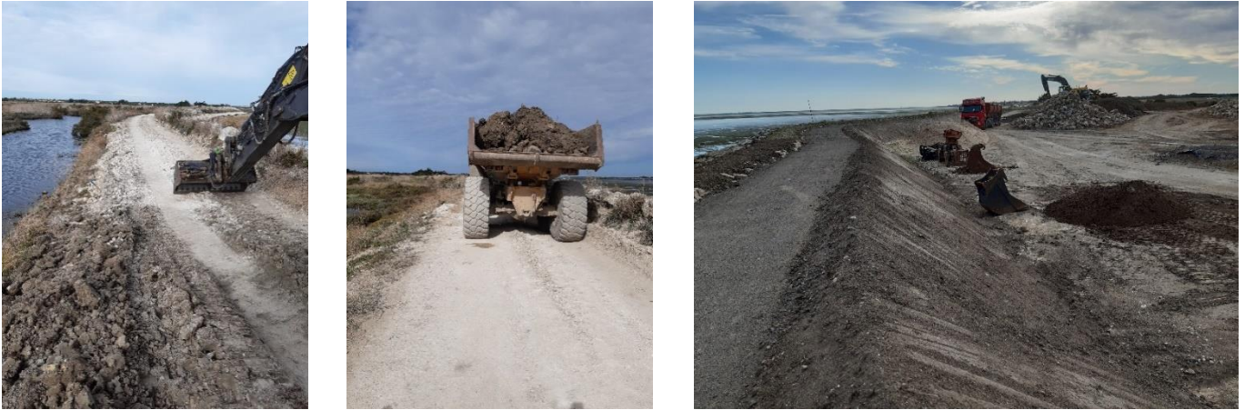
Figure 7. Préparation du sol support et évacuation des déblais
