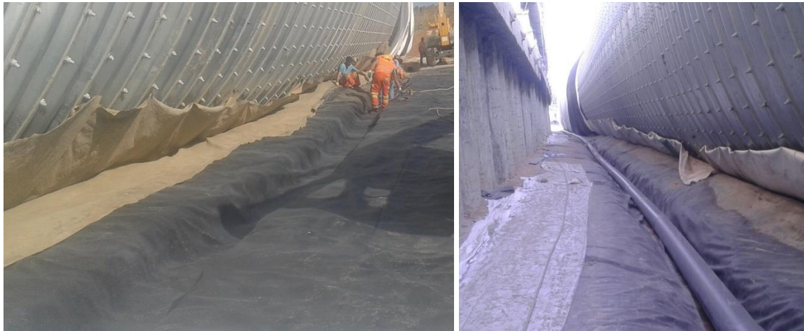
Figure 9. Tuyau de drainage le long du tunnel
