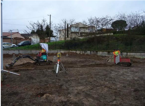
Figures 28 et 29. Terrassements emprises R1 et R2 – Profilage pour l'évacuation des eaux pluviales
