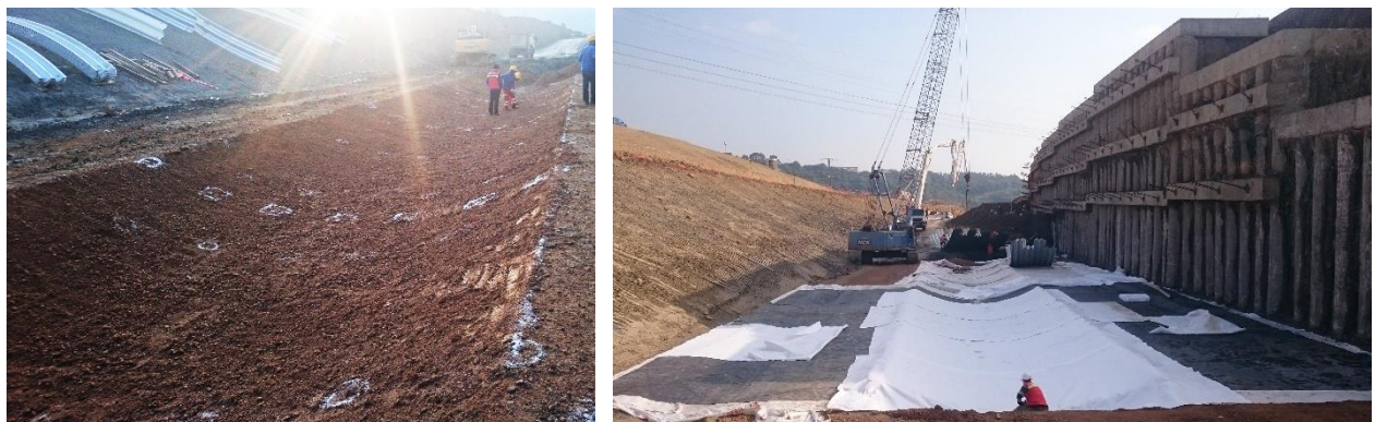
Figure 11. Préparation du support et mise en place des géosynthétiques (partie inférieure)
