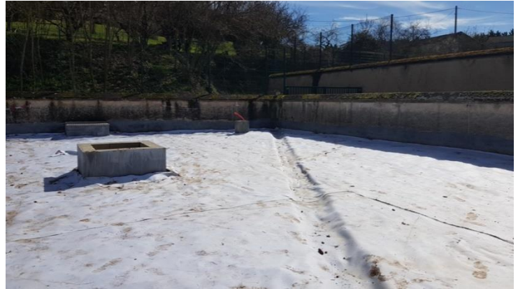
Figures 28 et 29. Terrassements emprises R1 et R2 – Profilage pour l'évacuation des eaux pluviales
