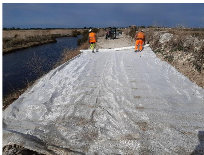
Figures 8. Déploiement de la géogridde
