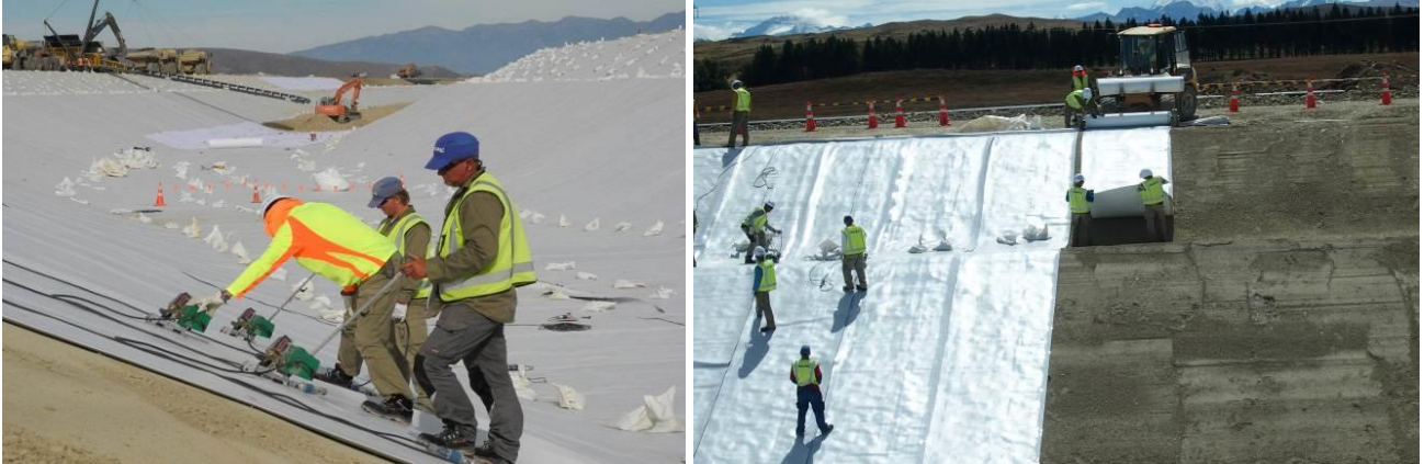
Figure 3. Déroulage des lés de géomembrane composée, et soudure des lés adjacents. En arrière-plan, mise en place du lestage sur la géomembrane composée.
